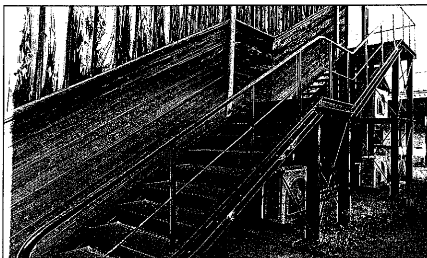
腐蝕して危険な非常階段でしたが、安全になりました
